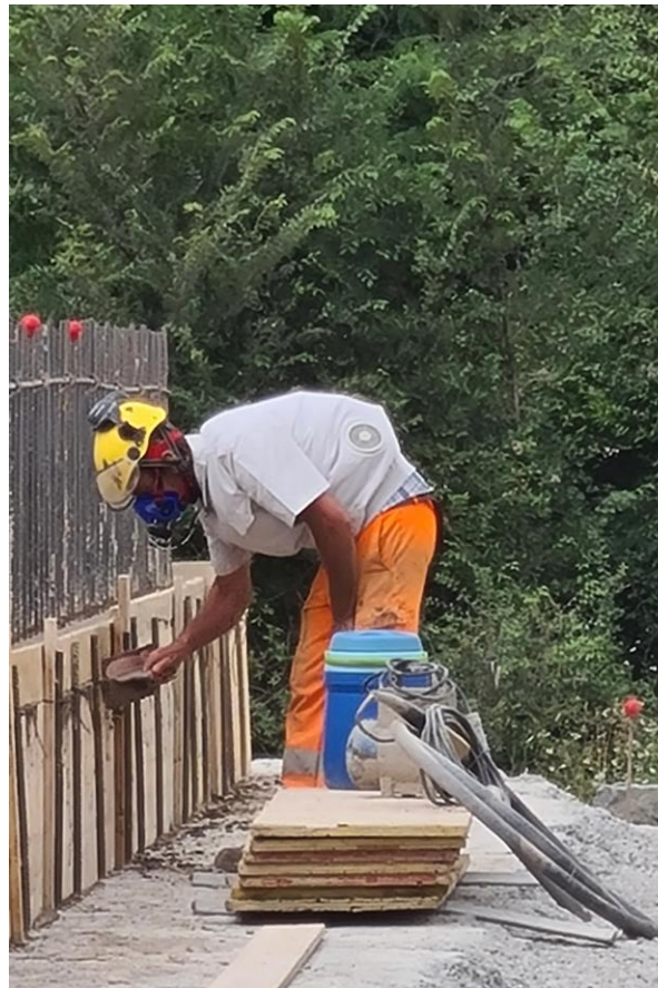
pulitura del calcestruzzo uscito dai casseri dopo il getto
