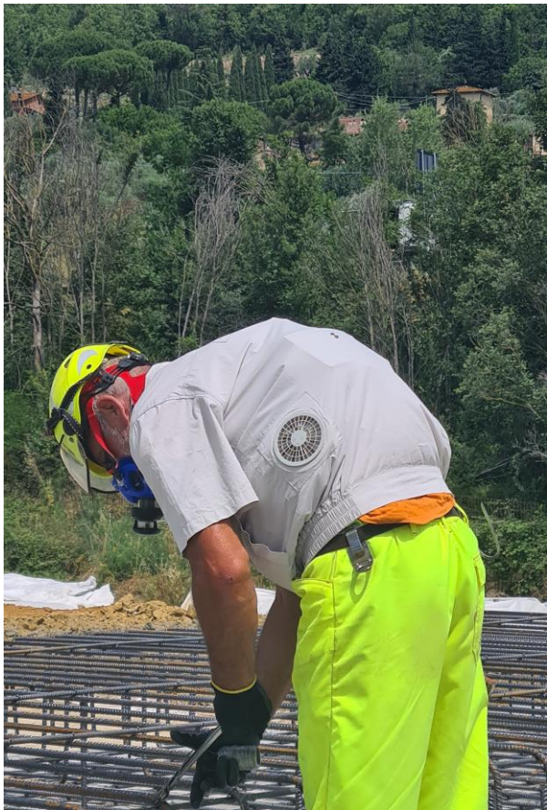
Legatura dei ferri di armatura di una platea o di una parete
