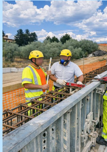
Armatura cordolo di una FOA
